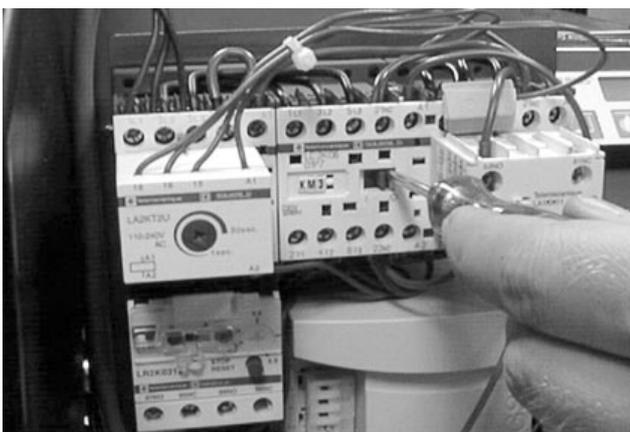
После завершения работ по подключению необходимо проверить правильность подключения электропроводки и задействовав кратковременно защиту электродвигателя горелки с помощью изолированной отвёртки, проверить направление его вращения.
